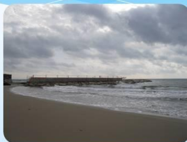
Osserviamo la costruzione del nuovo molo.
